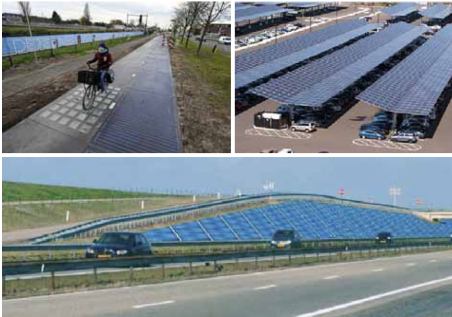
Voorbeelden dubbelgebruik van zonnepanelen: zonedijk Eemshaven (bron: Solarfields), boven een parkeerterrein en op het dijklichaam langs de Afsluitdijk (bron: De Ingenieur)
